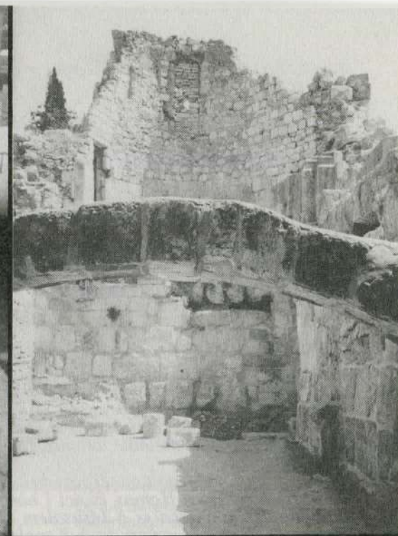
Ruines de la piscine de Bethesda
