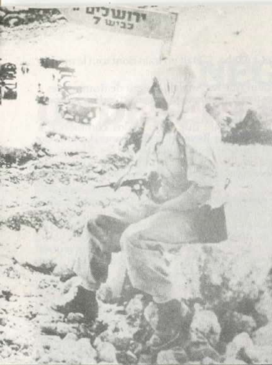
Construction de la "Route de Birmanie" pendant la guerre d'indépendance.
