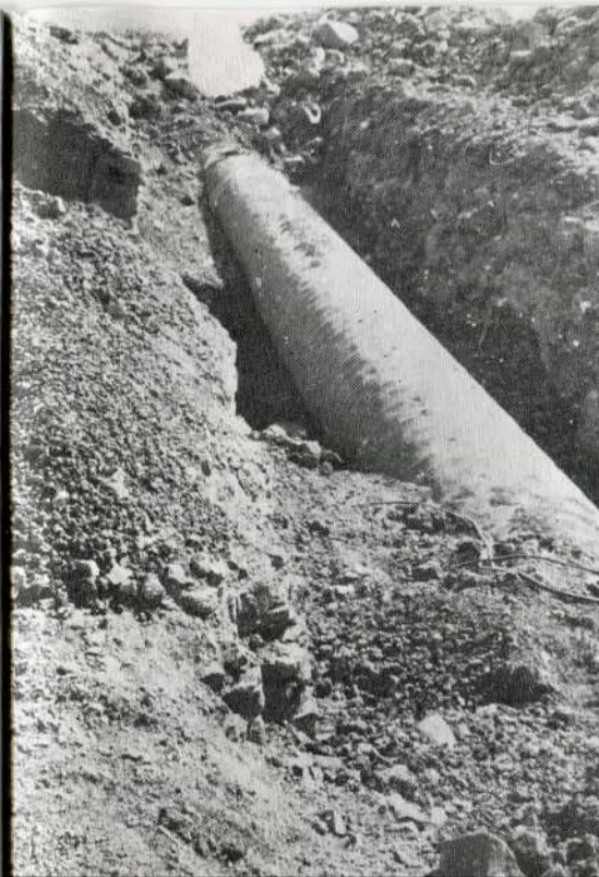
Travaux d'irrigation sur le Golan.
