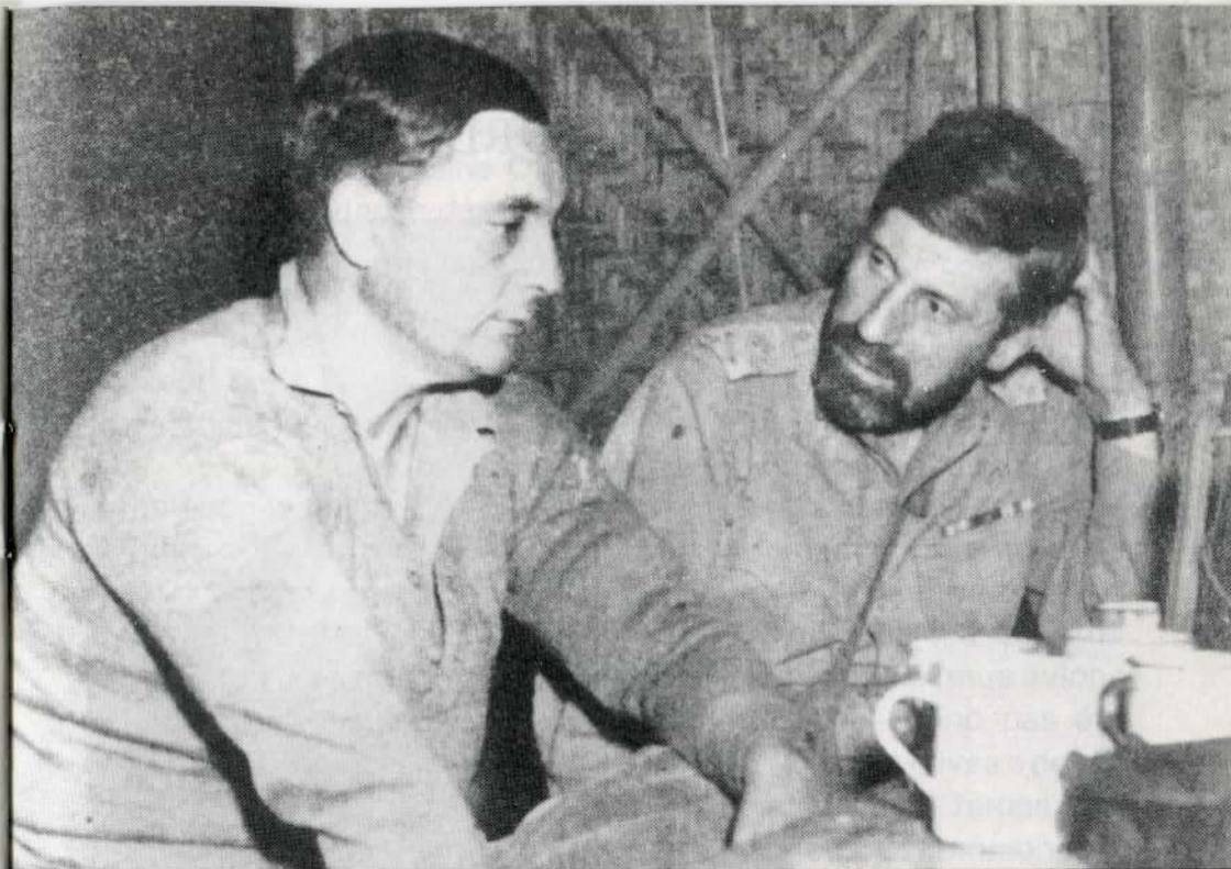
Orde Wingate (à droite) dans sa tente de commandement lors de la campagne de Birmanie 1944
